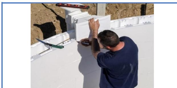
Установка закладных элементов (разметка контура)
