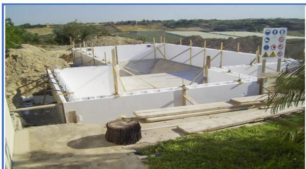
Установка элементов пространственной жесткости опалубки ISOBLOK
