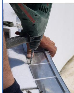
Установка и фиксация направляющей из алюминия
