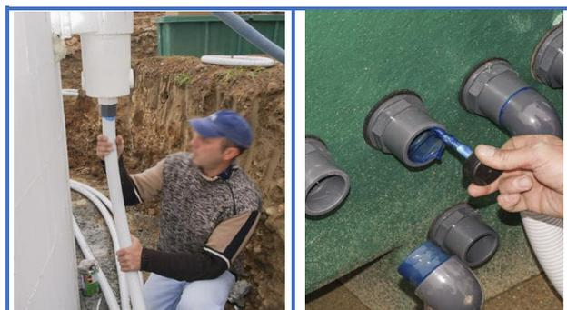
Подсоединение к гидравлической системе закладных деталей
