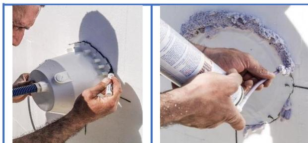
Установка закладных элементов, разметка и запенивание
