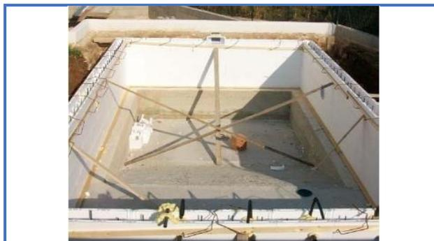
Установка элементов пространственной жесткости опалубки ISOBLOK
